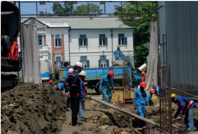
▲ Pile cap concrete pouring
